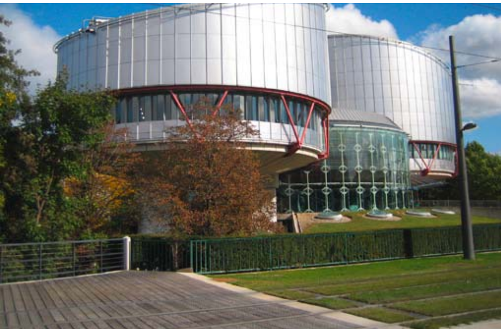
Neues Menschenrechtsgebäude. Straßburg, Frankreich
