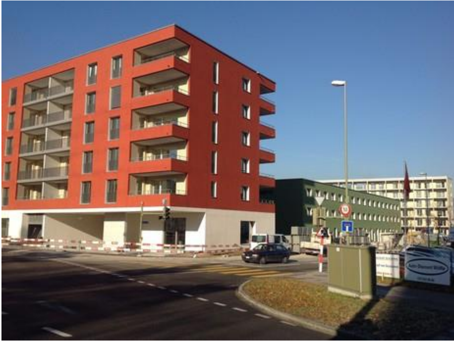
so präsentiert sich das neue Quartier von der Badenerstrasse aus gesehen
