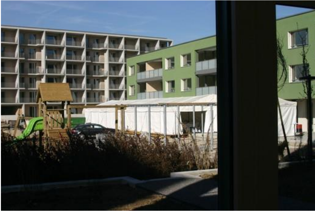
Das Gebäude im Hintergrund wird einen Monat später, im Mai, bezugsbereit sein
