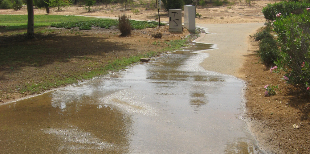
Bild 2 – Stauwässer auf Grund inadäquaten Designs und/oder Handhabung des Bewässerungssystems in einem Böschungsbereich. Foto: Avigail Heller
